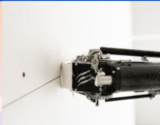
Aplicare banda de imbinare si pasta la perete cu imbinare placi gips carton
