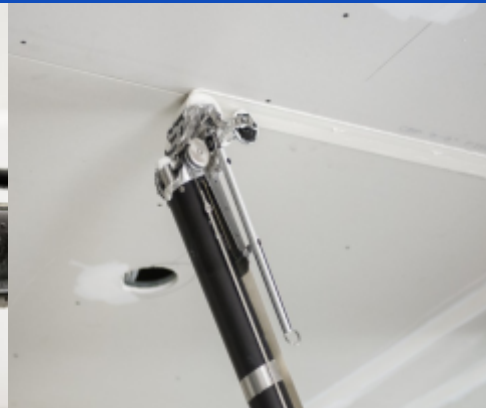
Aplicare banda de imbinare si pasta la plafon cu imbinare placi gips carton
